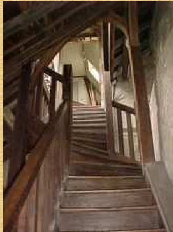
Escalier sur cour
