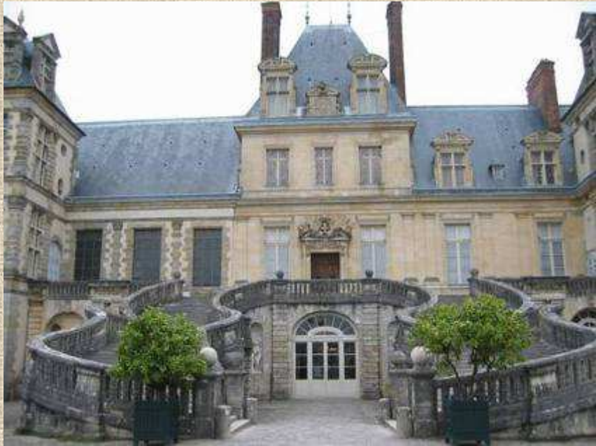
Entrée du château de Fontainebleau
