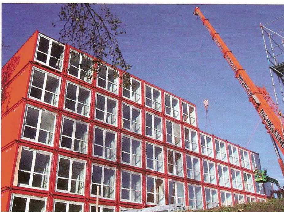
Une solution rapide : les conteneurs transformés en habitation.
