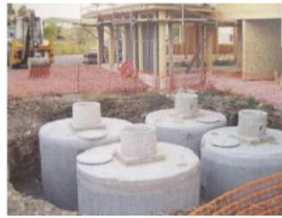
a L'installation de cuves en béton
