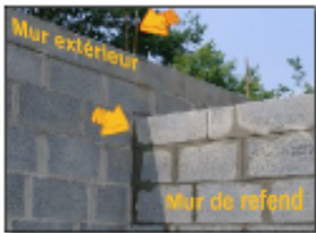
Chainages verticaux et horizontaux
